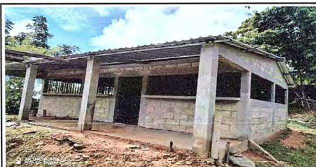
Foto 5: ES EL PROCESO DE ENTECHADO Y VIGAS, COSTANERAS DE LA COCINA
