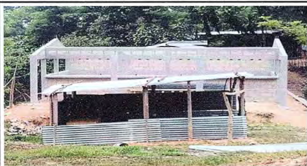
Foto 1: ES EL PROCESO DE REMODELAMIENTO DE LA COCINA.
